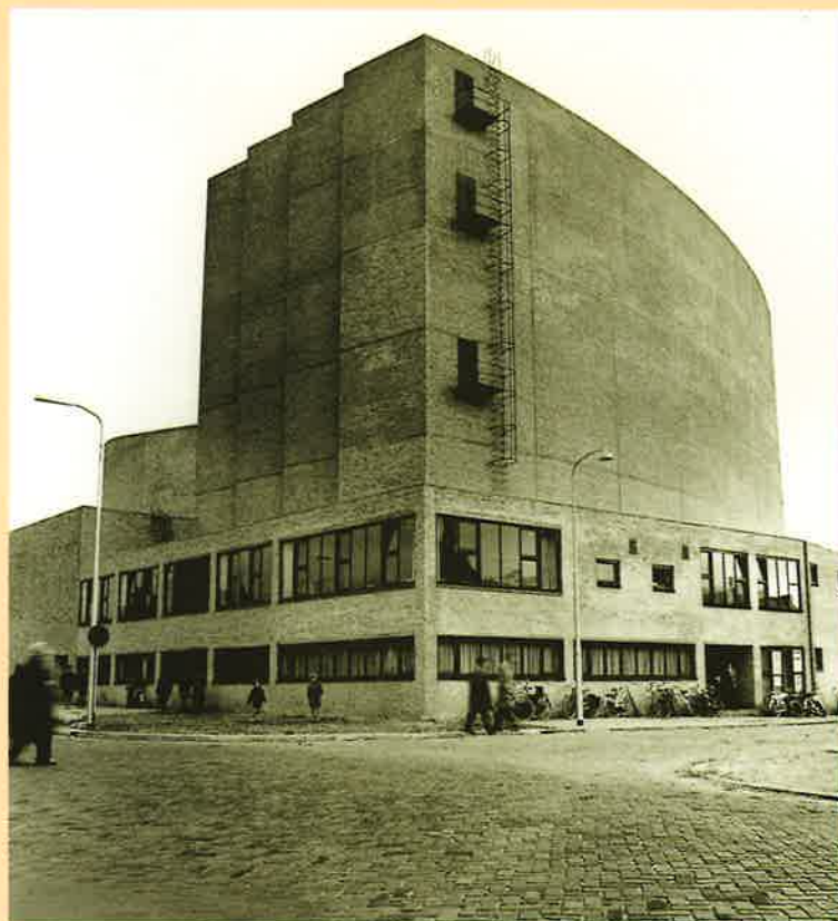
Achter-aanzicht Schouwburg Tilburg (Bijvoet & Holt)
