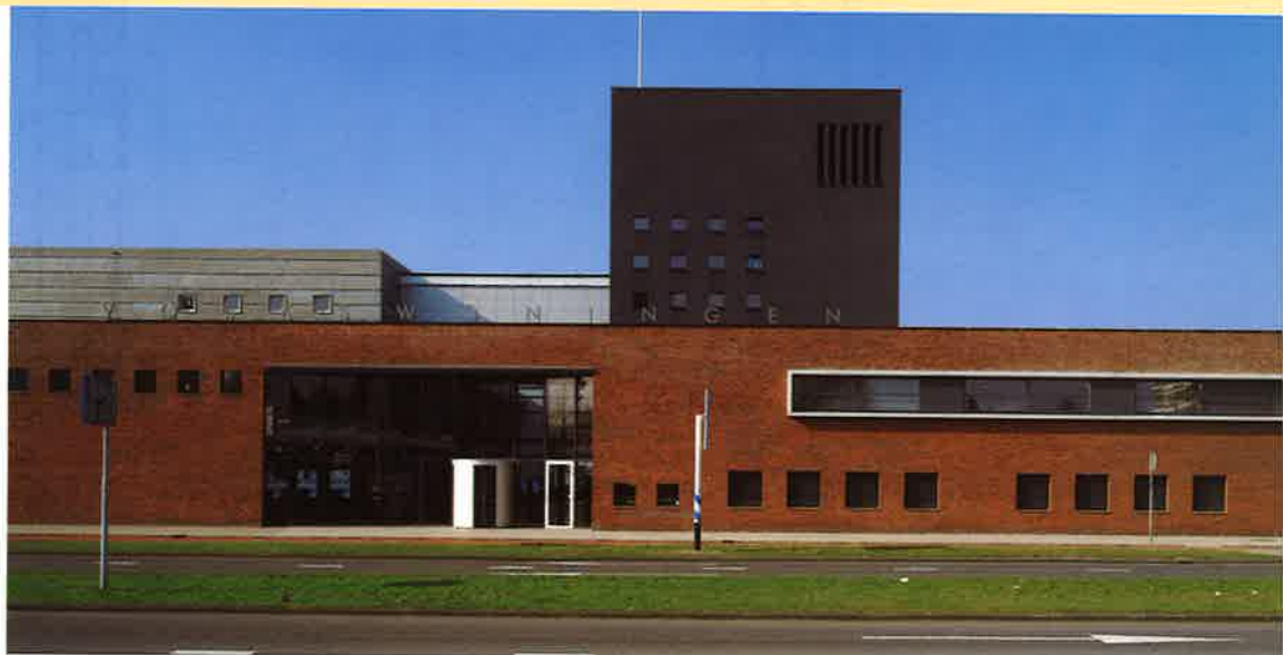
Kantoor 'Volkswoningen', Prinsenland, Rotterdam (Dobbelaar De Kovel De Vroom Architecten)
