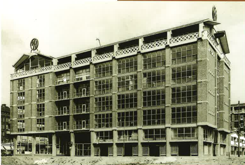
Industrigebouw Goudsesingel, Rotterdam, 1949 (W. Van Tijen & H.A. Maaskant)
