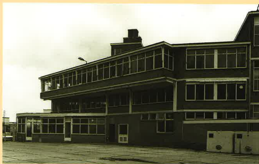
Bedrijfsgebouw Amsterdam, 1959 (M. Stam)
